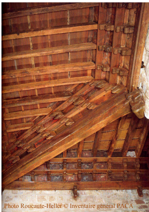
Photo Roucaute-Heller © Inventaire général PACA Vue de la charpente, angle Nord-Est
